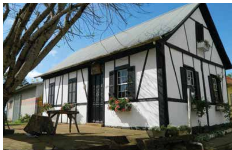
... Armazém Kieling, construído entre 1869 e 1879. A porta de entrada, em madeira com desenhos talhados, era tradição na Alemanha ... Geschäftshaus Kieling, erbaut zwischen 1869 und 1879. Die Eingangstür aus Holz mit geschnitzten Mustern, war Tradition in Deutschland ... Foto: Daniela Moraes
